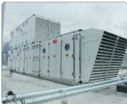
Fot. Centrala w wykonaniu higienicznym przeznaczona dla pomieszczeń czystych. Widoczne charakterystyczne okienka inspekcyjne stosowane dla ułatwienia kontroli stanu czystości w centrali wentylacyjnej bez konieczności wyłączenia i otwierania urządzenia (z arch. Clima Gold).
